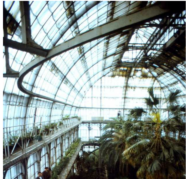
11.sz.ábra FELÚJÍTÁS ALATT HŐSZIGETELŐ ÜVEGGEL
